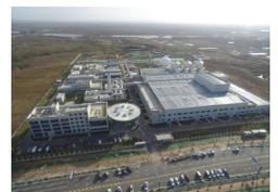
Im „Hefei Xiaomiao Organic Waste Treatment Center Project“ werden organische Abfälle vorbehandelt und mittels anaerobe Vergärung in einer knapp 67.000 Quadratmeter großen Anlage in Biogas umgewandelt. Zwei biogasbetriebene Jenbacher J420 Gen-Sets versorgen nicht nur die Anlage mit elektrischer Energie, sondern speisen auch Strom in das örtliche Stromnetz ein.
