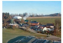
Mit dem Einbau eines Jenbacher J420 Motors und der Investition in einen großen Pufferspeicher und einen Gasspeicher wurde die Biogasanlage des deutschen Landwirtschaftsbetriebs Heslerhof zu einem regenerativen Speicherkraftwerk mit flexibler, strommarktgeführter Fahrweise umgebaut. Der Heslerhof erzeugt seinen eigenen Strom und deckt damit seinen gesamten Eigenbedarf. Überschüssiger Strom wird bei attraktiven Einspeisetarifen zum Marktpreis ins öffentliche Netz eingespeist.
