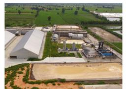
Fünf biogasbetriebe Jenbacher J420 Motoren erzeugen mehr als genug elektrische Energie, um die Tapiokastärkefabrik der Chok Yuen Yong Industry Co., LTD zu versorgen. Der überschüssige Strom – rund 1.000 kW – wird in das öffentliche Netz eingespeist, wodurch sich die Stromkosten der Fabrik noch weiter reduzieren.
